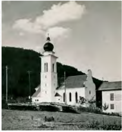
Die Fritznener Pfarrkirche bei ihrer Fertigstellung 1933
